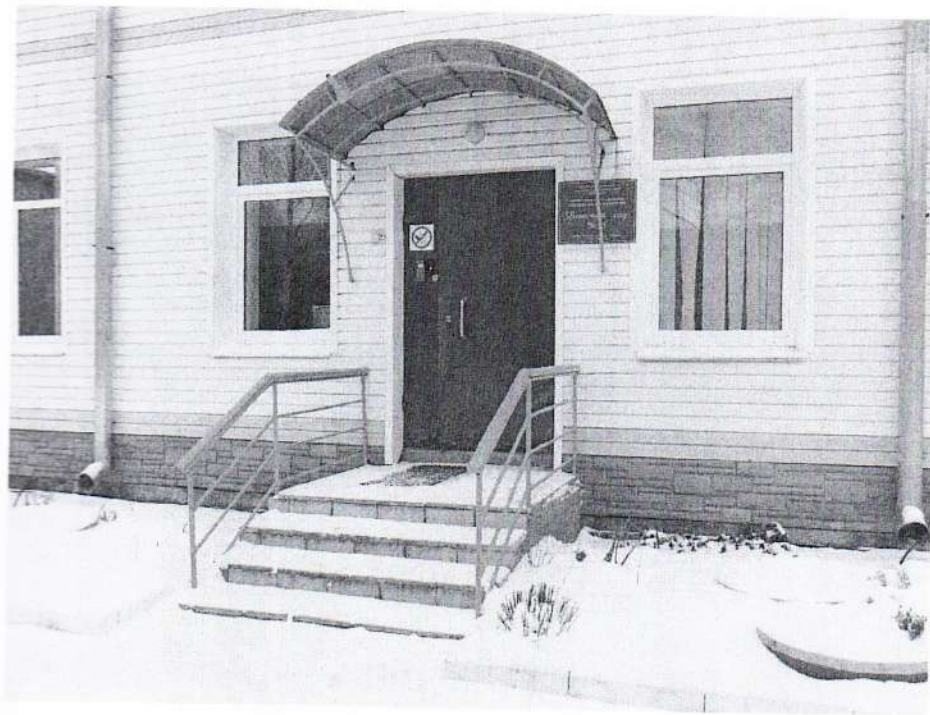
Территория, прилегающая к зданию
